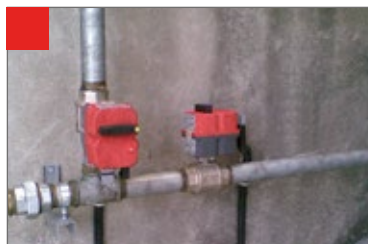
ELETRÓVALVULA HIDRÁULICA ELECTROVANNE HYDRAULIQUE HYDRAULIC SOLENOIDE VALVE ELEKTROVENTIL ELECTROVALVULA HYDRAULICA
